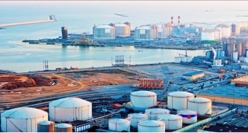
Gás natural liquefeito ou GNL (da sigla em inglês LNG - *liquefied natural gas*) é basicamente gás natural que, após purificado, é condensado ao estado líquido por meio da redução da sua temperatura a 163 °C.
