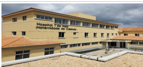
*Em curso a reabilitação e requalificação total da Maternidade 1º de Maio – Cabinda
