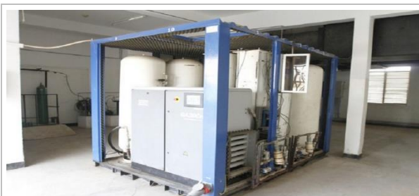
* Montagem de fábrica de oxigénio do Hospital do Sumbe– Cuanza Sul, 2020
